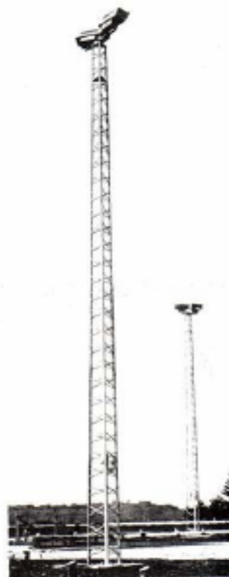
Pylônes LT-3-48 sur un terrain de baseball.
