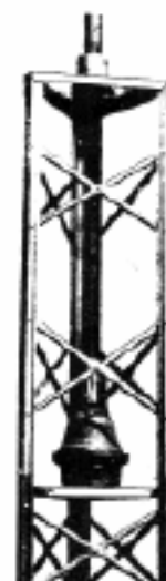
Section du sommet d'un pylône d'amateur avec un rotateur, le mât et un modèle BOMB installés.
