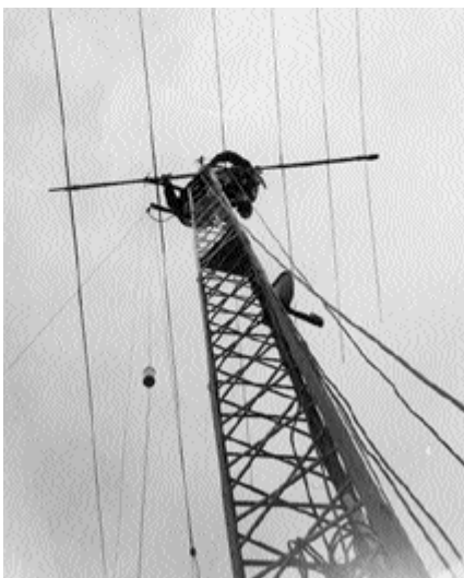
La tour et l'une des antennes directionnelles
